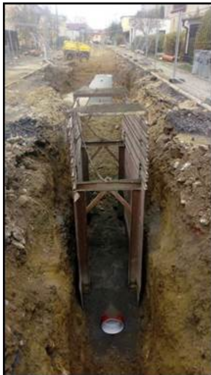
Obr. 8: Na stavbě je sice používáno systémové pažení s plánem BOZP. (zdroj: [neznámý])
