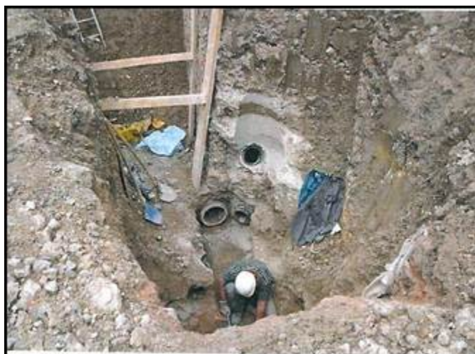
Obr. 7: Práce v hloubce více jak 5 m. (zdroj: materiály VÚBP, v. v. i.)
