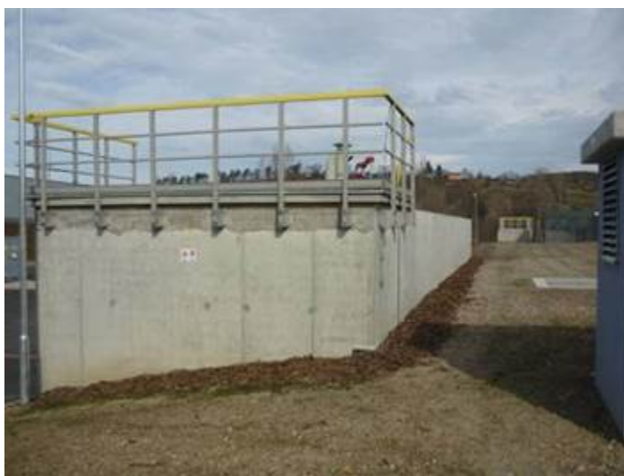
Obr. č. 3: Příklad kůrového filtru (Regenerace) nad biologickou částí NVL ÚČOV Praha (vlevo) a příklad kůrového filtru nacházejícího se u západní fasády podzemní části NVL ÚČOV Praha (vpravo) (foto: VÚBP, v. v. i.)
