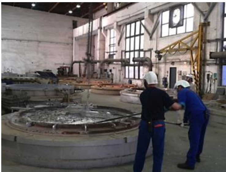
Obr. č. 9 Hala rafinace - část rafinačních kotlů
